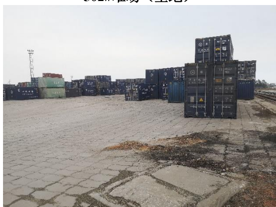
504#堆场 (堆存集装箱)
