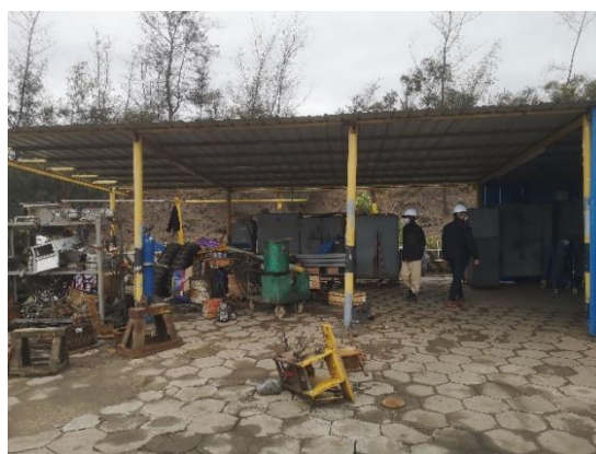
集装箱堆场大件维修间
