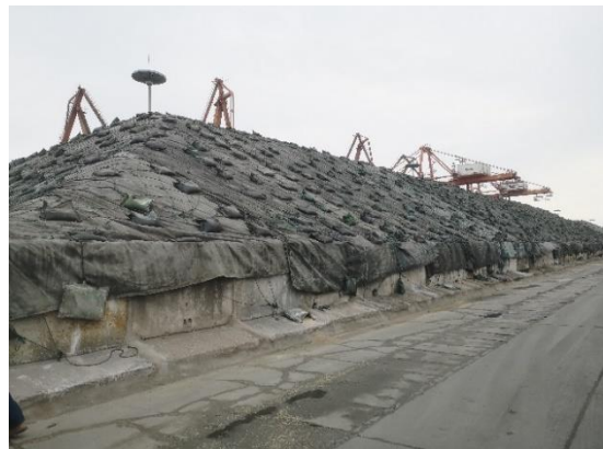
401#化肥堆垛防雨篷布苫盖
