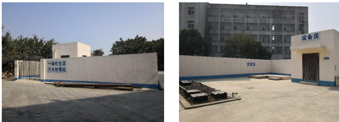
图 5.2-4 生活污水处理站现场照片
