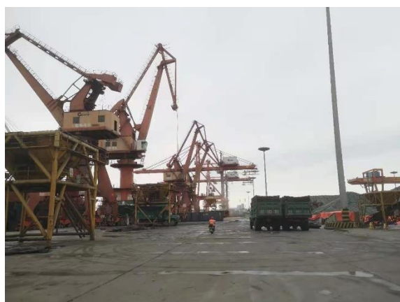
码头前沿卸船漏斗
