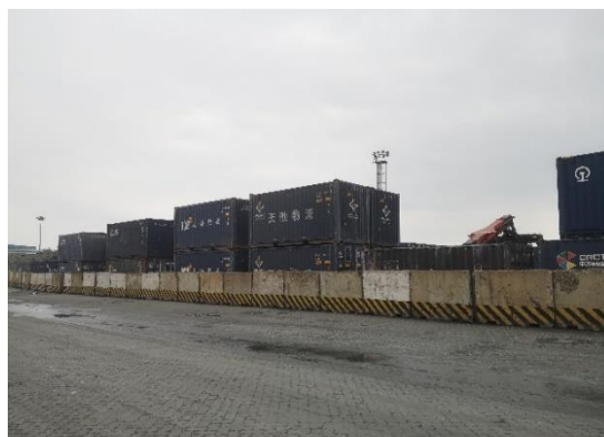
302#堆场 (堆存集装箱)
