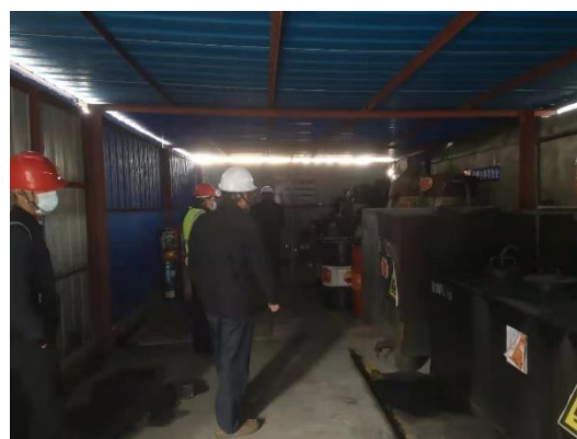
危废暂存间内部
