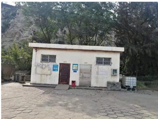
熏蒸区设备及药品间
