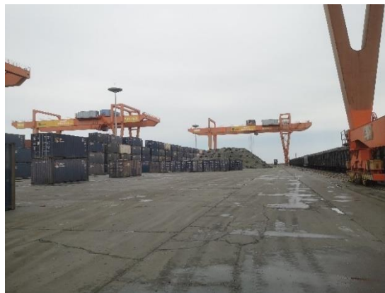
402#堆场（堆存集装箱）
