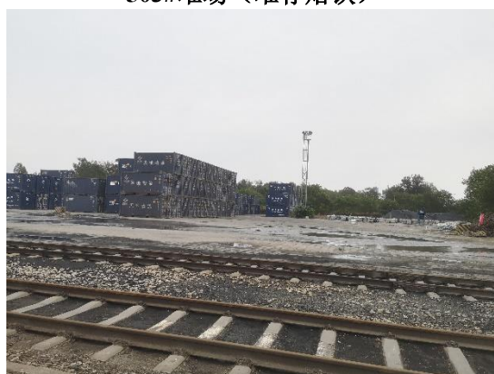
505#堆场 (堆存集装箱)
