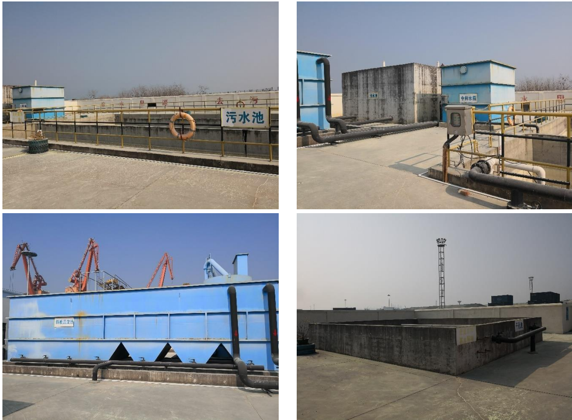
含尘污水处理站
