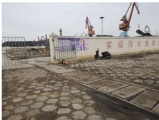
501#堆场含尘污水处理站
