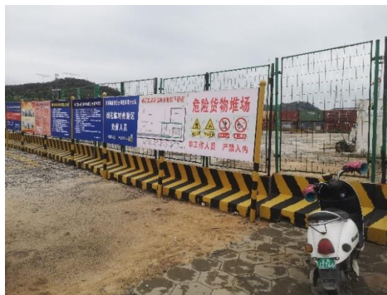
烟花爆竹临时查验区（已关闭，待拆除）
