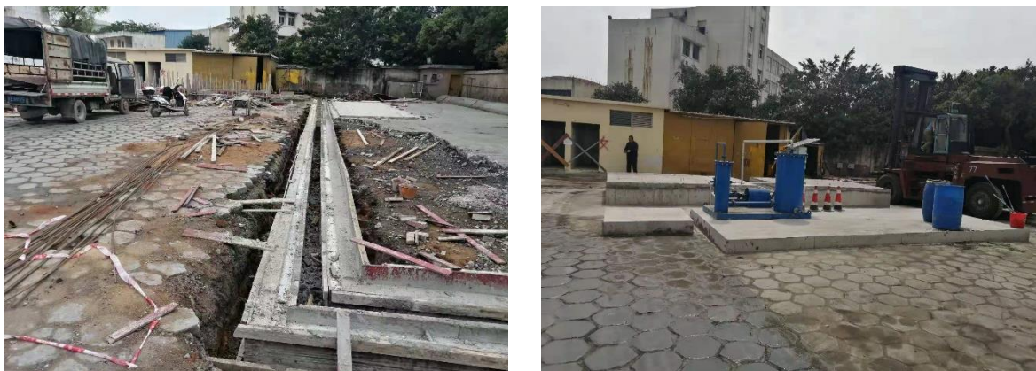
洗车台污水收集池（在建）
